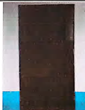
FOTO 4: SUSTITUCIÓN DE PUERTAS
