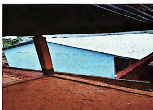
FOTO2: ESTRUCTURA DE TECHO POR METAL
