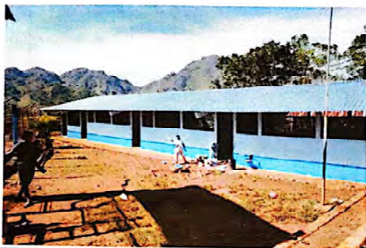
FOTO1: CUBIERTAS DE LÁMINAS TROQUELADAS CALIBRE 26
