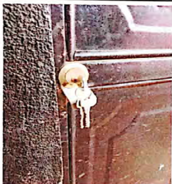
FOTO 3: SUSTITUCIÓN DE CHAPAS
